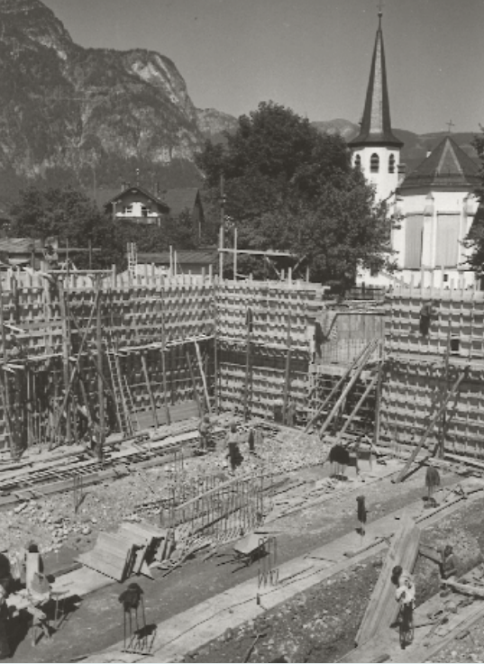
Baustelle des Olympia-Hallenbads im Sommer 1939 mit der evangelischen Kirche im Hintergrund
