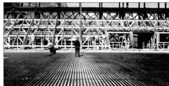
Olympia Eisstadion am Bahnhof im Bau
