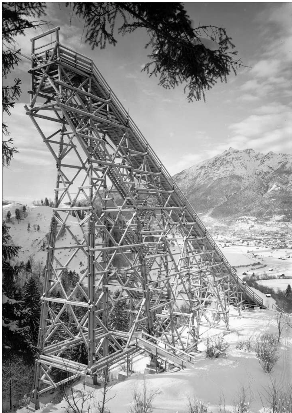
Als Anlauf bei der Großen Schanze diente ein 43 Meter hoher und 5 Meter breiter, hölzerner Anlaufurm auf Betonfundamenten
