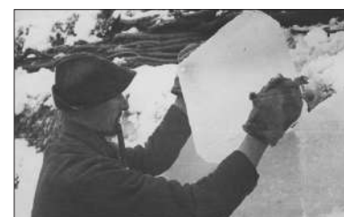
Die Ausmauerung der Kurven geschah durch einheimische Maurer mit hochkant gestellten Eisplatten im Format 28 x 28 cm, die aus dem Eis des Riessersees geschnitten worden waren Foto: Rudophi, Marktarchiv Garmisch-Partenkirchen
