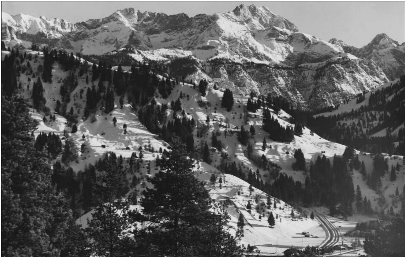
Der Gudiberg vor dem Beginn der Baumaßnahmen für die olympischen Spiele mit der alten „Olympiaschanze“ und der Rodelbahn Foto: Bayerische Staatsbibliothek München / Fotoarchiv Johannes
