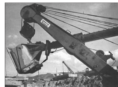
Anders als 1936 wurden 1939 für Erdarbeiten Bagger verwendet Foto: Blumenthal, Marktarchiv Garmisch-Partenkirchen
