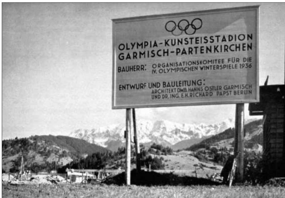
Bautafel für das Olympia-Eisstadion. In der Nähe des Bahnhofs Garmisch- Partenkirchen Foto: Blumenthal, Marktarchiv Garmisch- Partenkirchen
