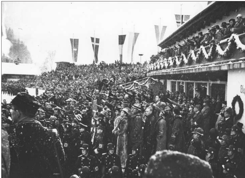
SA-Männer sperren den Zugang zur Ehrentribüne am Olympiahaus Foto: Blumenthal, Marktarchiv Garmisch-Partenkirchen
