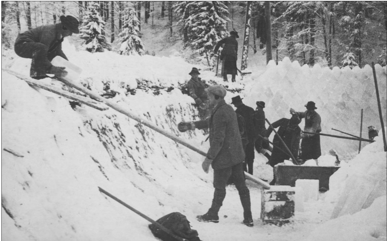
Einheimische Maurer machten in Tag- und Nachtarbeit trotz ungünstiger Witterungsverhältnisse die Bobbahn rennfertig Foto: Blumenthal, Marktarchiv Garmisch-Partenkirchen
