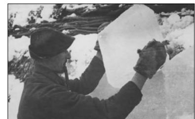
Die Ausmauerung der Kurven geschah durch einheimische Maurer mit hochkant gestellten Eisplatten im Format 28 x 28 cm, die aus dem Eis des Riessersees geschnitten worden waren Foto: Rudophi, Marktarchiv Garmisch-Partenkirchen
