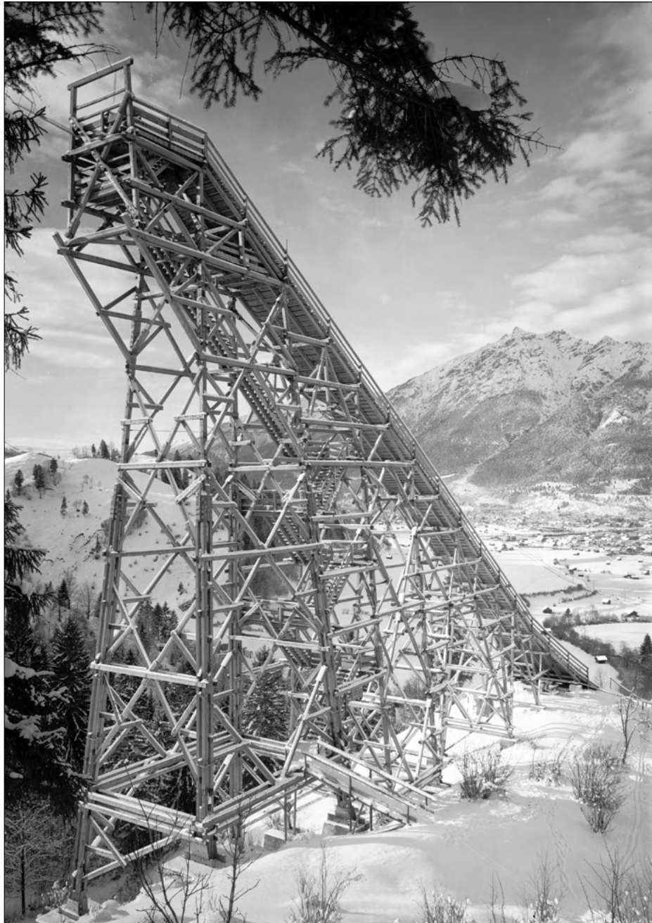
Als Anlauf bei der Großen Schanze diente ein 43 Meter hoher und 5 Meter breiter, hölzerner Anlaufturm auf Betonfundamenten
