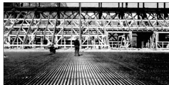
Olympia Eisstadion am Bahnhof im Bau
