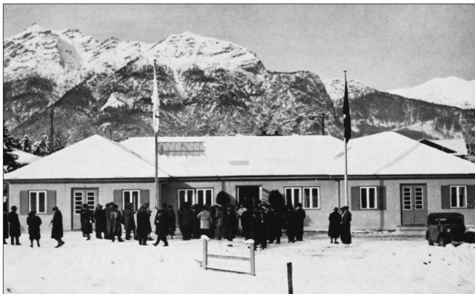
Zur medizinischen Versorgung wurde am Gudiberg ein Sportärztehaus errichtet Foto: Schirner, Amtlicher Bericht IV. Olympische Winterspiele 1936, S. 222
