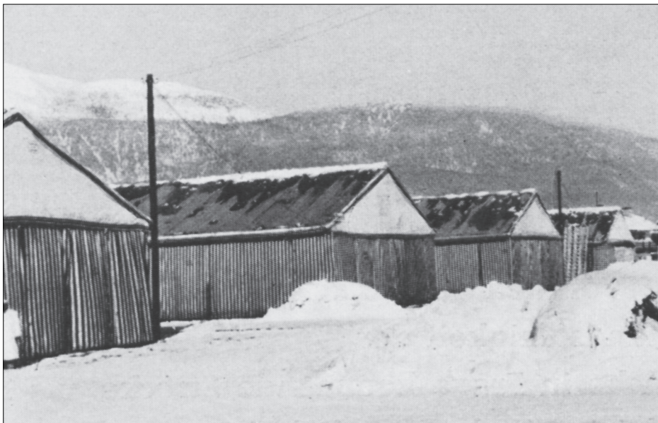
Für Besucher-Fahrzeuge, die für mehrere Tage abgestellt werden sollten, wurden in der Nähe des alten Bahnhofs Garagenzelte errichtet Foto: privat, Amtlicher Bericht IV. Olympische Winterspiele 1936, S. 199
