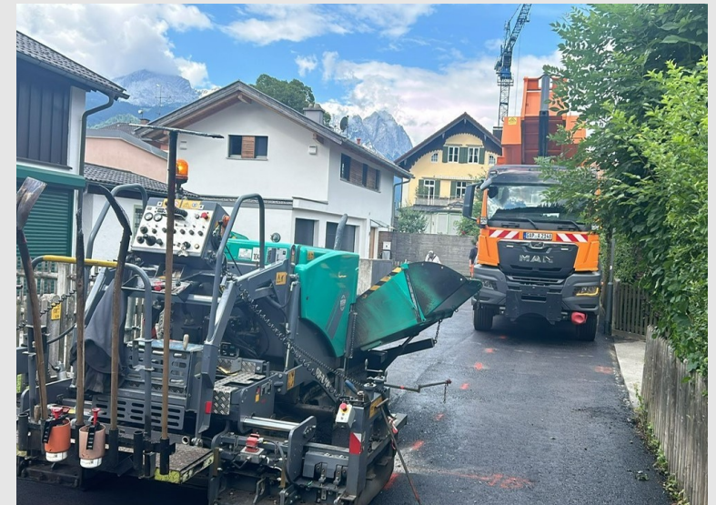
Sanierung Straße „Forsterweg“
