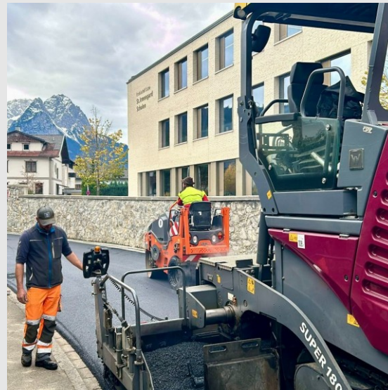
Sanierung Asphalt „Am Lyzeum“
