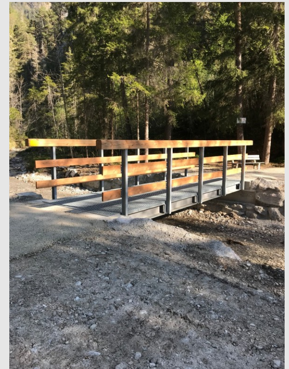
Kramerlaine-Brücke Instand gesetzt
