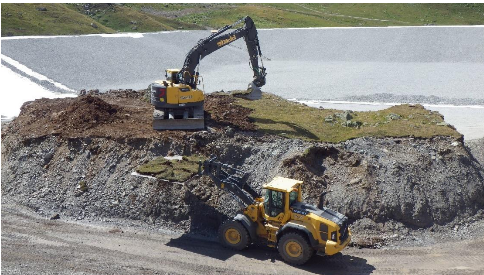
Abb. 22: Bergen, fachgerechter Transport und sofortiger Wiedereinbau (kurze Zeitspanne zwischen Bergen und Wiedereinbauen) von großflächigen Rasenziegeln.
