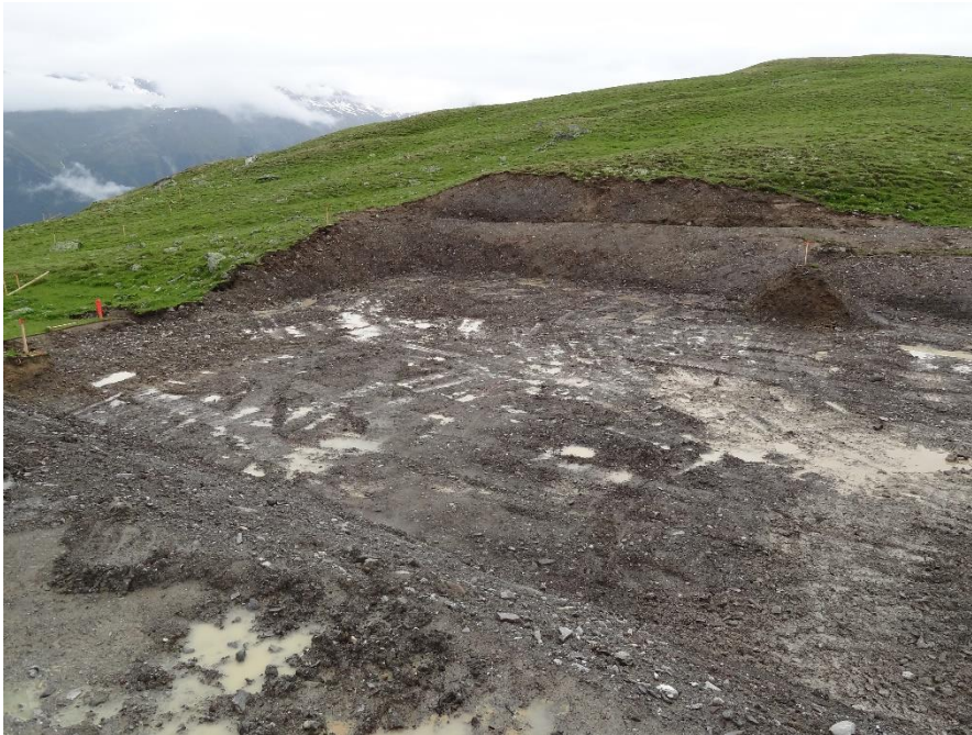
Abb. 19: Herstellung und Stabilisierung der Dammaufstandsfläche. Alle Flächen, die aktuell nicht bearbeitet werden, bleiben vorerst von Baumaßnahmen unberührt.
