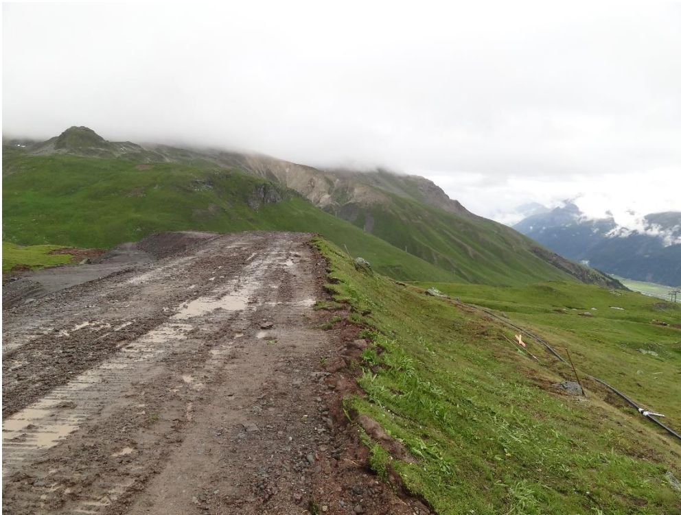
Abb. 21: Stabiler Aufbau des Dammkörpers mit sofortigem Einbau (Stoß an Stoß) der in unmittelbarer Nähe geborgenen Rasensoden (= sofortiger Erosionsschutz der Dammaußenböschung).
