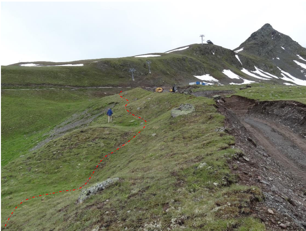
Abb. 20: Dammaufbau mit sofortigem Einbau (Stoß an Stoß) der in unmittelbarer Nähe geborgenen Rasenziegel. Rot strichliert dargestellt ist der Übergang vom Urgelände / Böschungsfuß der Dammschüttböschung. Dieses Foto wurde 3 Tage nach Baubeginn aufgenommen.
