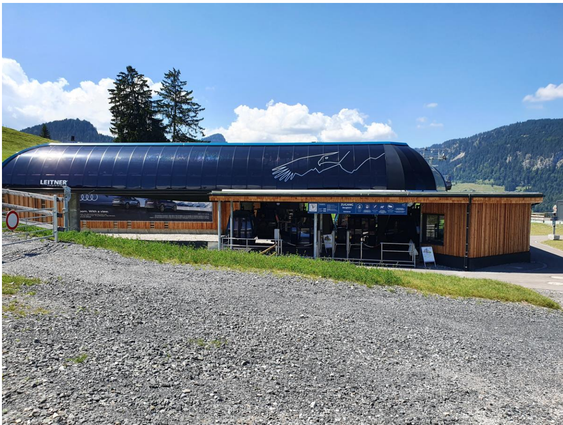
Abb. 6: Vergleichbare, eingehauste Mittelstation einer Seilbahn (Söllereckbahn, Oberstdorfer Bergbahn AG, LK Oberallgäu).
