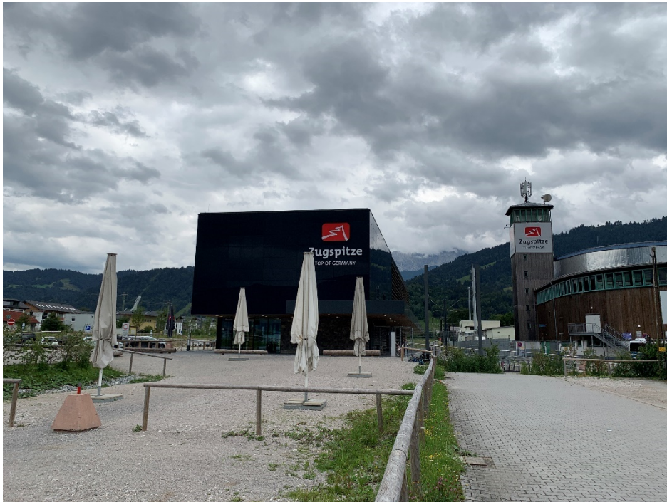
Abb. 5: Ansicht von Nordwesten – Neubau Bahnhof Zugspitzbahn; Foto Jocham + Kellhuber (Juli 2022)
