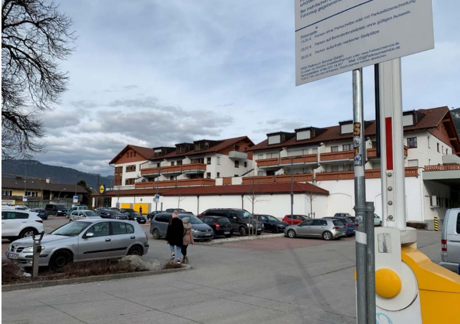
Abb.: Ansicht von Südwesten – Wohn- und Geschäftsgebäude Olympiastraße 25 a; Foto Jocham + Kellhuber (Februar 2020)
