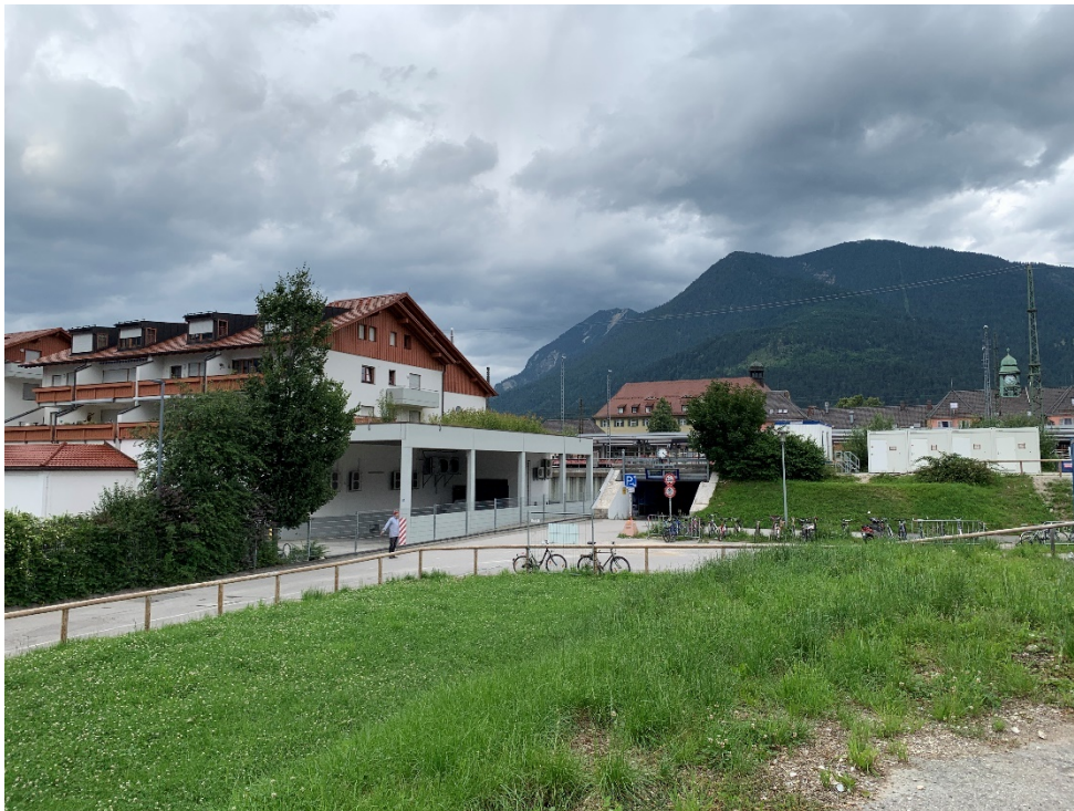
Abb. 8: Ansicht von Westen – nördliche Bahnhofsunterführung; Foto Jocham + Kellhuber (Juli 2022)
