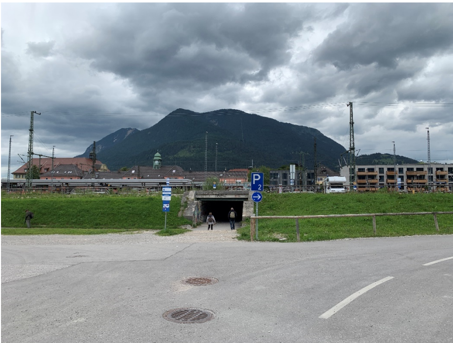
Abb. 7: Ansicht von Westen – südliche Bahnhofsunterführung; Foto Jocham + Kellhuber (Februar 2020)
