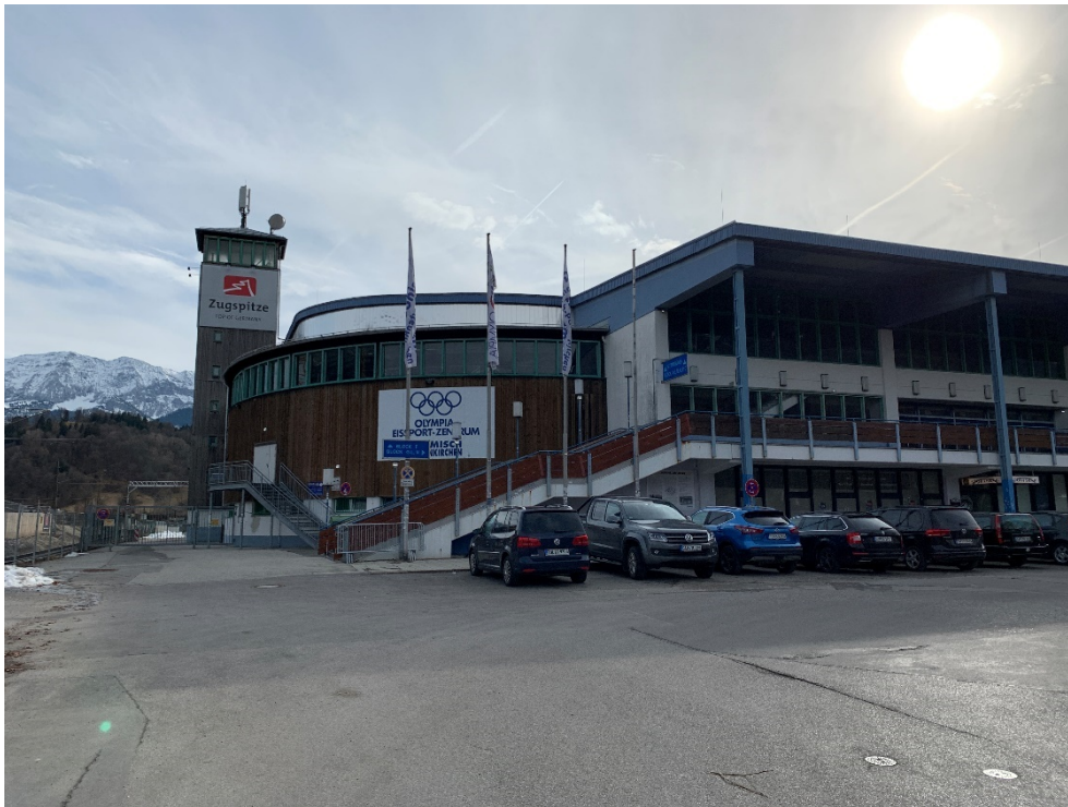
Abb. 9: Ansicht von Norden – Olympia-Eissport-Zentrum; Foto Jocham + Kellhuber (Februar 2020)
