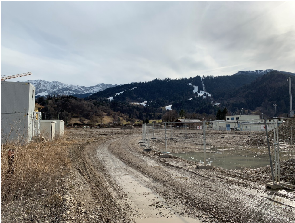
Abb. 5: Ansicht von Norden – Kies- und Ruderalflächen im Norden; Foto Jocham + Kellhuber (Februar 2020)
