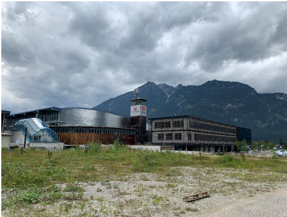
Abb. 6: Ansicht von Südosten – Kies- und Ruderalflächen; Foto Jocham + Kellhuber (Juli 2022)
