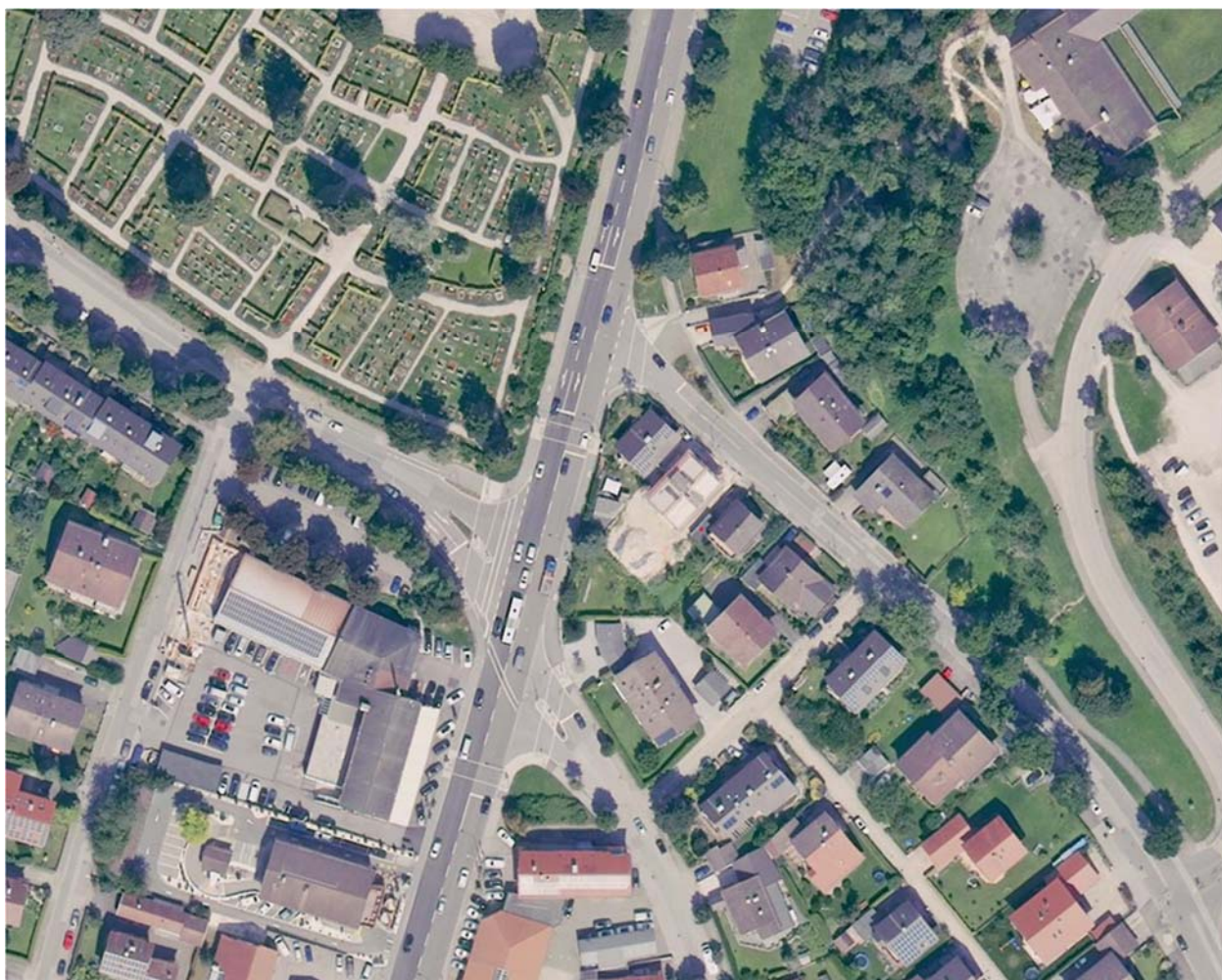
Abbildung 7: Luftbild Knotenpunkt Hauptstraße (B2) /Ferdinand-Barth-Straße/ Unterfeldstraße mit nördlich angrenzender Einmündung der östlichen Münchner Straße in die B2 [Quelle: Bayerische Vermessungsverwaltung 2022]
