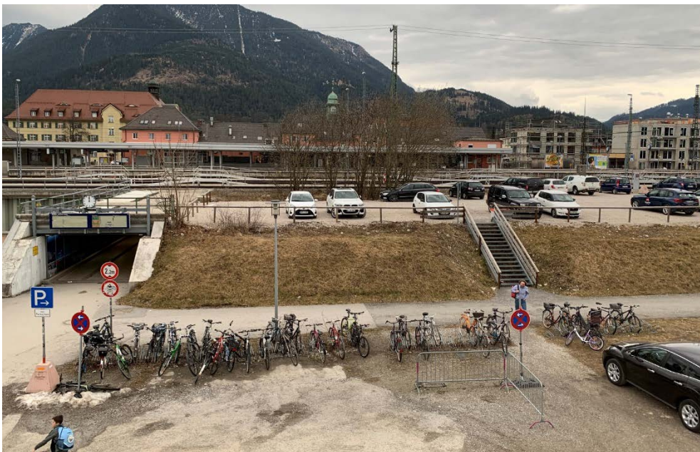
Abb. 22: Ansicht von Westen – Parkplatzflächen; Foto Jocham + Kellhuber (Februar 2020)
