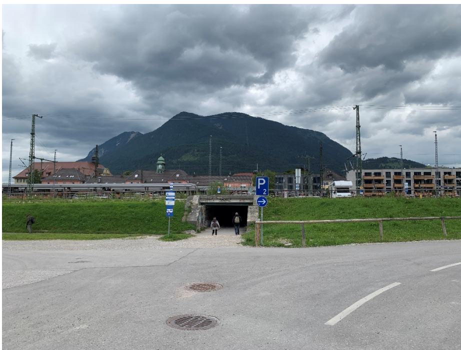
Abb. 7: Ansicht von Westen – südliche Bahnstufunterführung; Foto Jocham + Kellhuber (Februar 2020)
