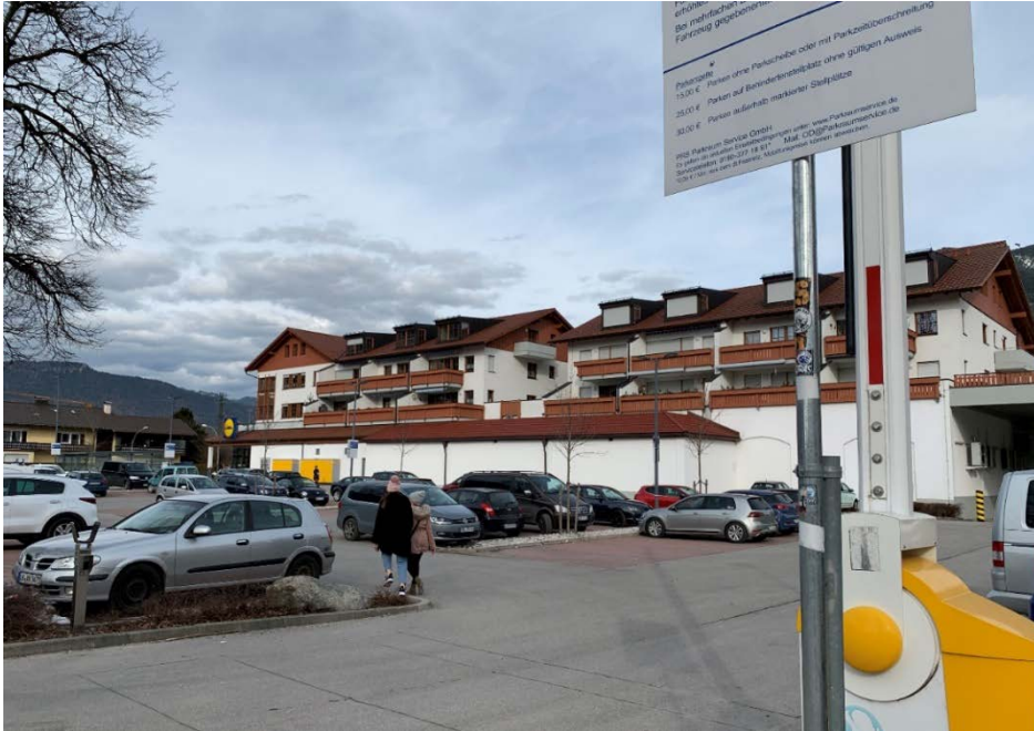
Abb.: Ansicht von Südwesten – Wohn- und Geschäftsgebäude Olympiastraße 25 a; Foto Jocham + Kellhuber (Februar 2020)
