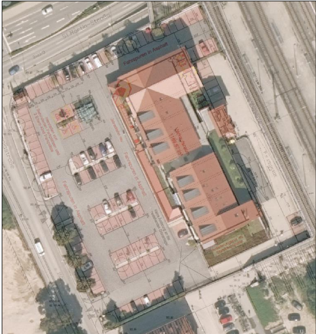
Abbildung 5. Gebäude Olympiastraße 25a ([2], [6]).
