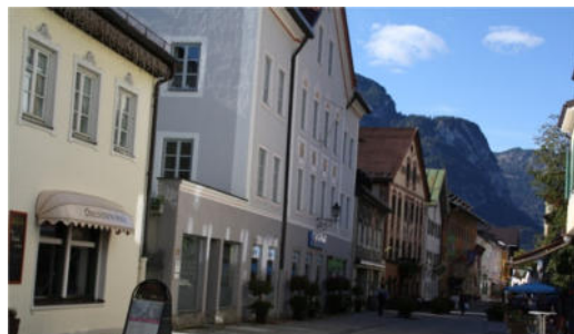
Geschlossene Raumkante der historischen Gebäude und Denkmäler
