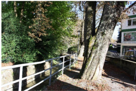
Kastanienreihe an der Kanker, Ausbau Hochwasserschutz geplant
