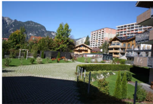
Komplett unterbautes Wohnquartier unterhalb des Riedweges
