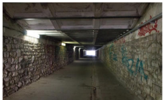
Vernachlässigte Unterführung am Bahnhof
