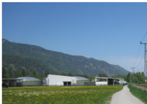
Gemeindewerke Garmisch Partenkirchen, Biogasanlage
