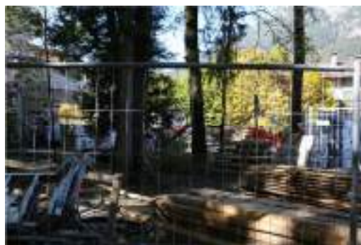
Lagerung von Baumaterial und Fahrzeugen / Kränen im Kronenbereich von Bäumen führt zu Verdichtung im Wurzelbereich und zu Schäden an Kronen und Stämmen. Dadurch kommt es zu Folgeschäden bis zum Absterben des Baumes.
